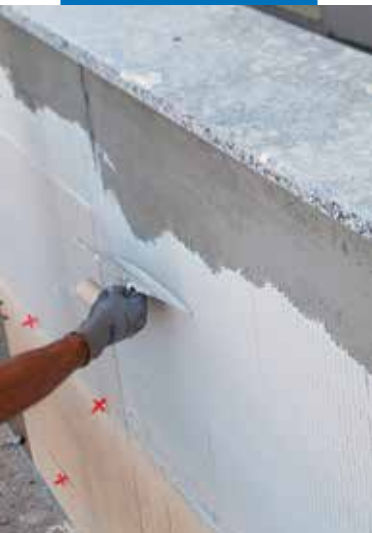
Posa su facciata esterna, applicazione dell'adesivo sul supporto
